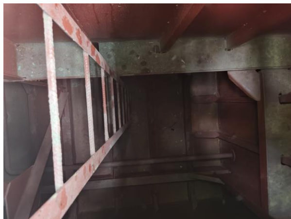
码头初期雨水及冲洗废水收集池
