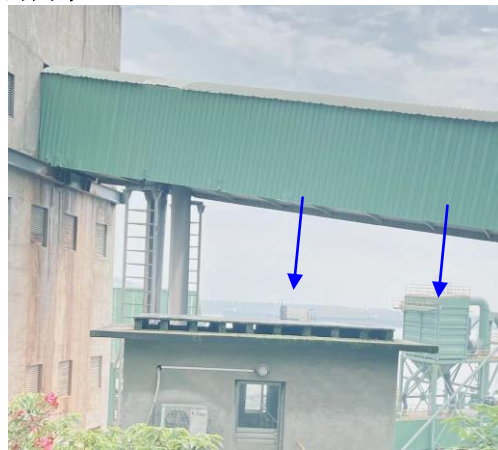
趸船处布袋除尘器
