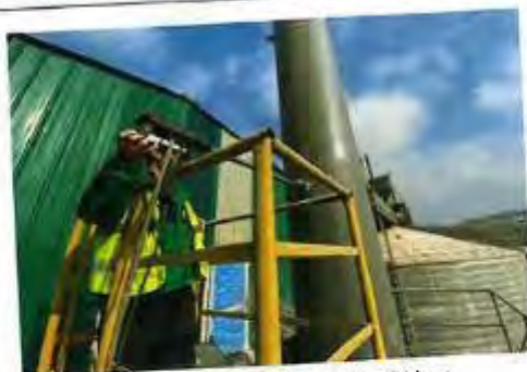
CDA044 机制砂筒仓废气排放口
