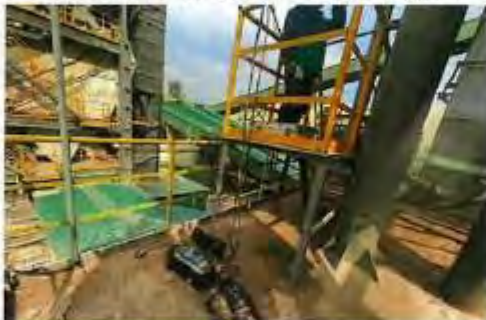
CDA026 制砂楼出料输送废气排放口
