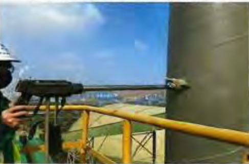
CDA040 骨料筒仓废气排放口
