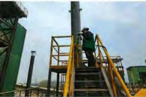
CDA037 搅拌楼进料输送废气排放口
