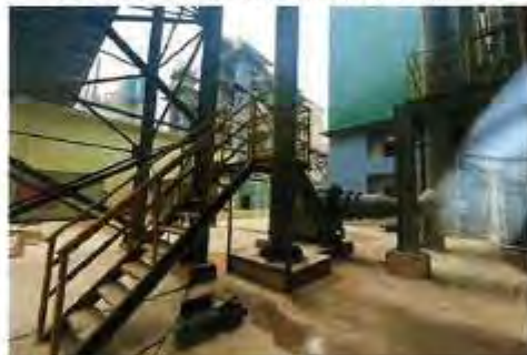
CDA030 搅拌楼进料输送废气排放口
