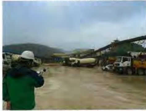
C区厂界西侧外1m处▲11
