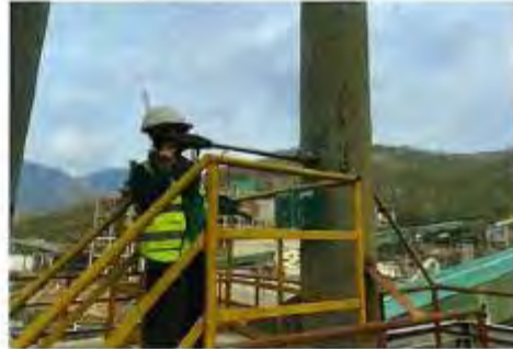
BDA011 回料破碎至水泥来料预筛分输送废气排放口
