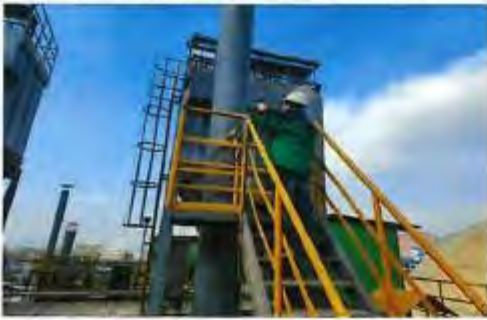
CDA035 搅拌楼进料输送废气排放口
