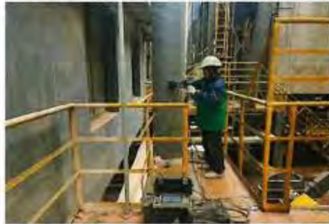
CDA039 搅拌楼物料斗提废气排气筒
