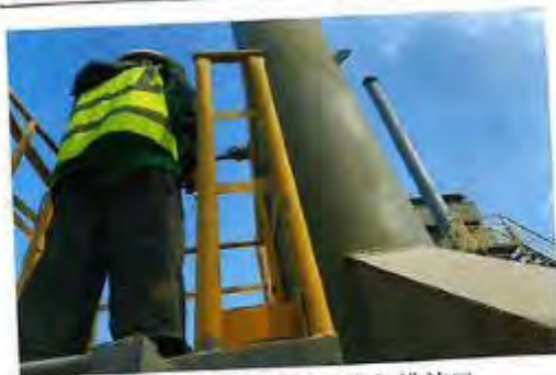
CDA042 机制砂筒仓废气排放口
