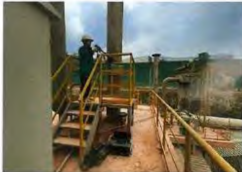
BDA013 水泥来料预筛分至水洗输送废气排放口
