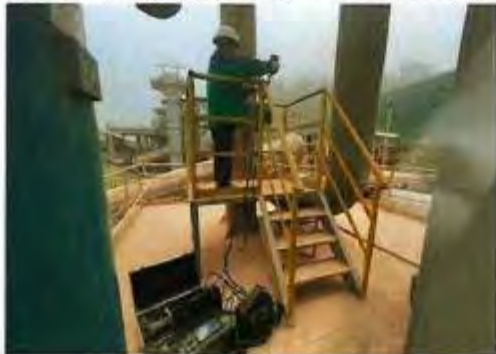
DDA016 廊道输送废气排放口
