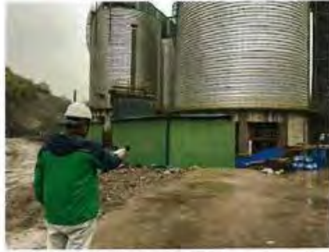
C区厂界东侧外1m处▲9
