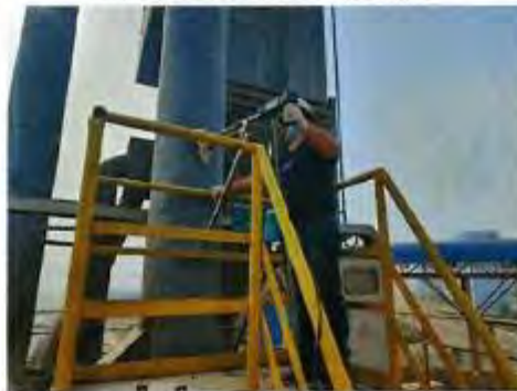
DDA017 廊道输送废气排放口
