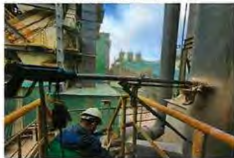
CDA027 搅拌楼进料输送废气排放口
