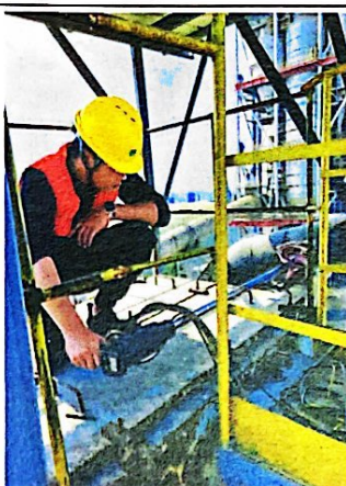
煤磨二号排气筒
