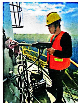
K2 线窑头废气处理设施排气筒
