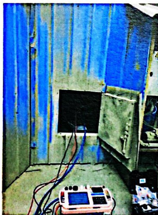
C2 线水泥磨排气筒
