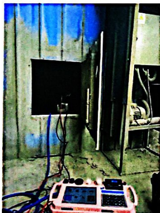
C1 线水泥磨排气筒
