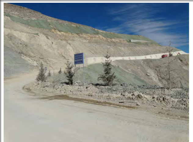
北矿区防护挡土墙（6m）
