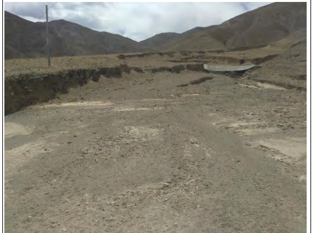
浆砌石防洪工程
