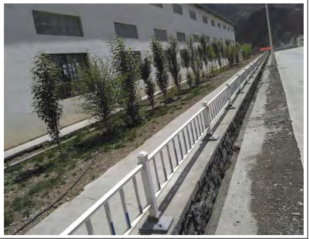
浆砌石排水沟（明渠）
