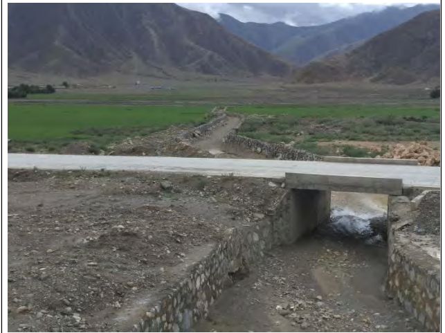
浆砌石排水沟（汇入夏布曲）
