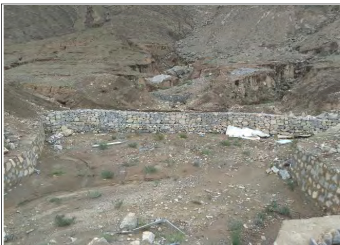
铅丝石笼挡墙（南侧 01）
