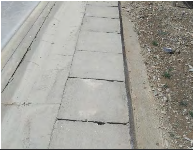
浆砌石排水沟（暗沟）
