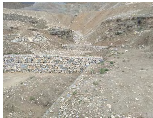
沟道中铅丝石笼挡墙群
