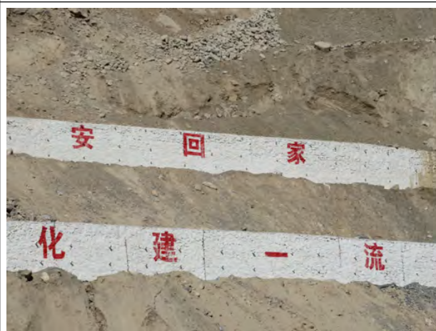
乡道防护挡土墙（3m）
